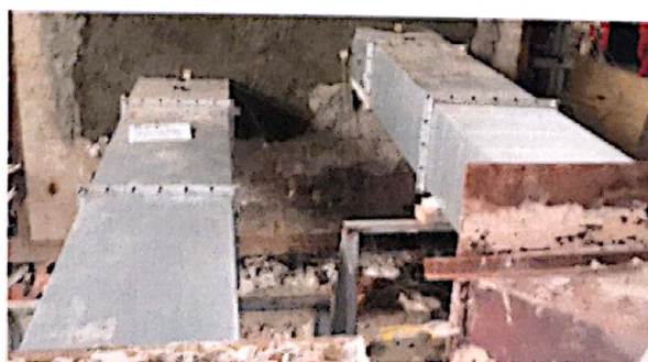
照片 2 耐火试验结束时试件情况
